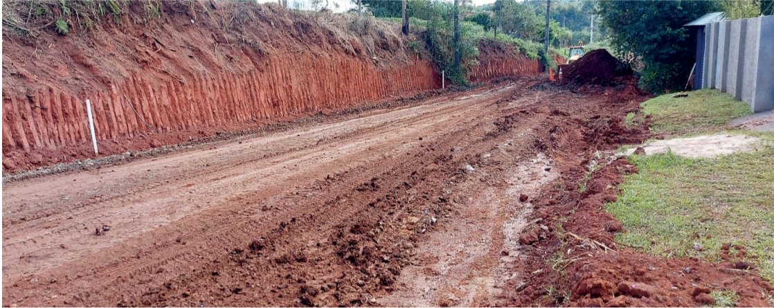
Rua Ernesto Nunes é uma das dez contempladas dentro do programa que destinou R$ 5 mi para pavimentação
