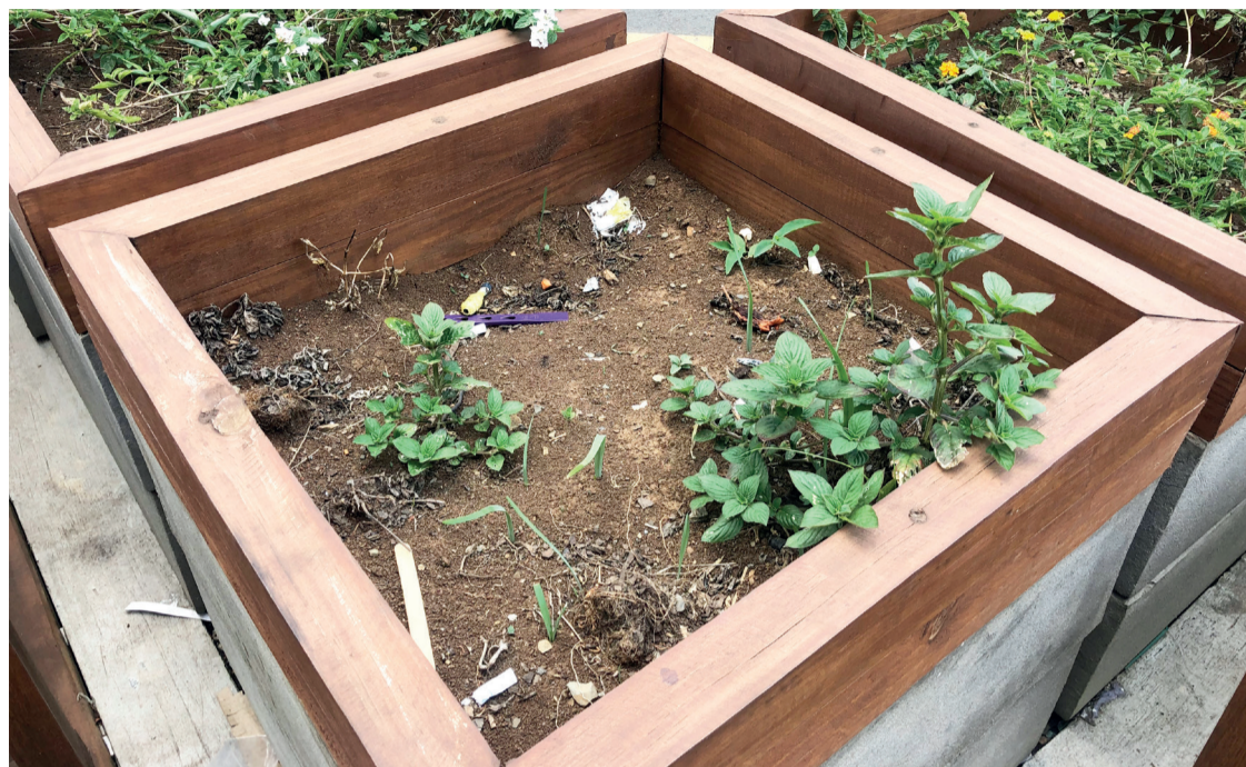
As pessoas estão depositando o lixo nas floreiras, na calçada e nas canalitas do Centro da cidade
