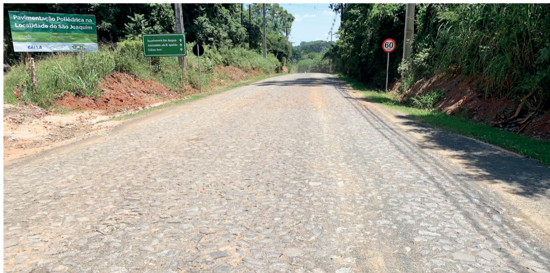
Outras duas obras estão em execução, ambas em pedras poliédricas por meio do Finisa
