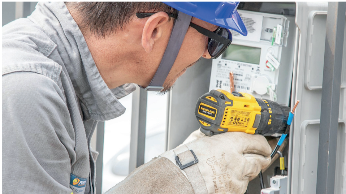
A troca dos medidores dura em média 30 minutos, com a unidade consumidora desligada
