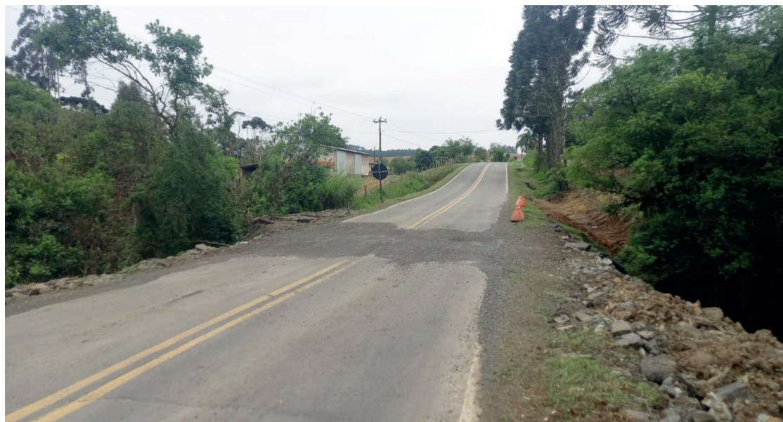
Obra será na altura do km 99+950, ficando a cerca de 350 metros da ponte sobre o Rio Preto
