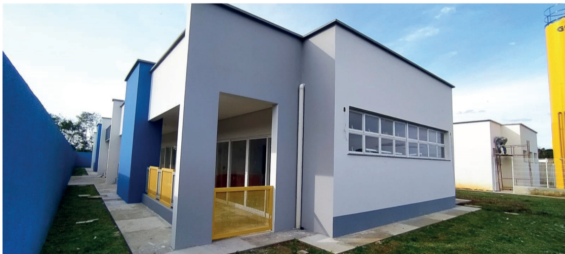
Prefeitura deu continuidade a construção da obra com recursos próprios do município
