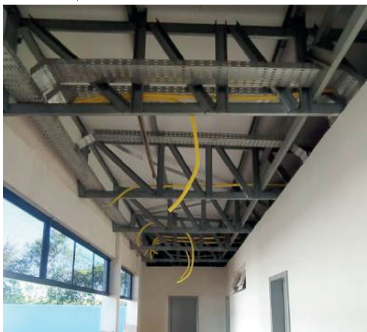
A nova creche conta com espaços externos com coberturas reforçadas
